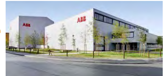
ABB: Neubau Produktionsfabrik und Laborgebäude für Hochspannungsschaltanlagen; Helbling Beratung + Bauplanung plante die gesamte Gebäudetechnik
