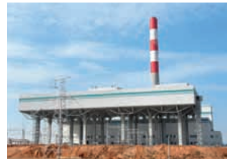
Luftgekühlte Kondensatoranlage des thermischen Kraftwerks Qingtongxia (2 x 330 MW), China
