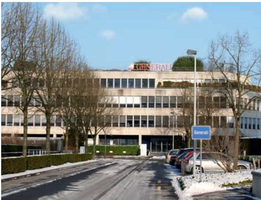
Hauptsitz der Generali Schweiz Versicherungen: Generalplaner Ertüchtigung Rechenzentrum
