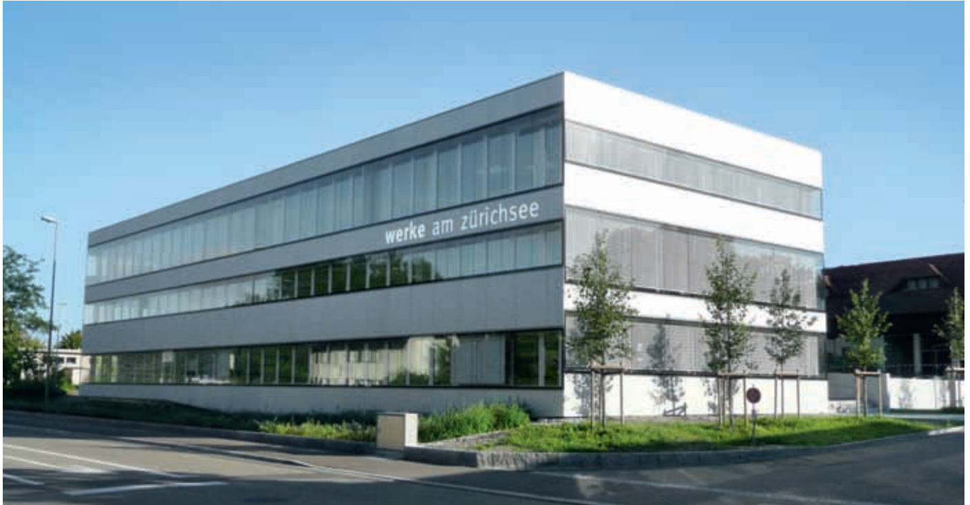
Neubau Werkhof/Bürogebäude in Küsnacht für drei Gemeinden: Bauherrenvertretung
